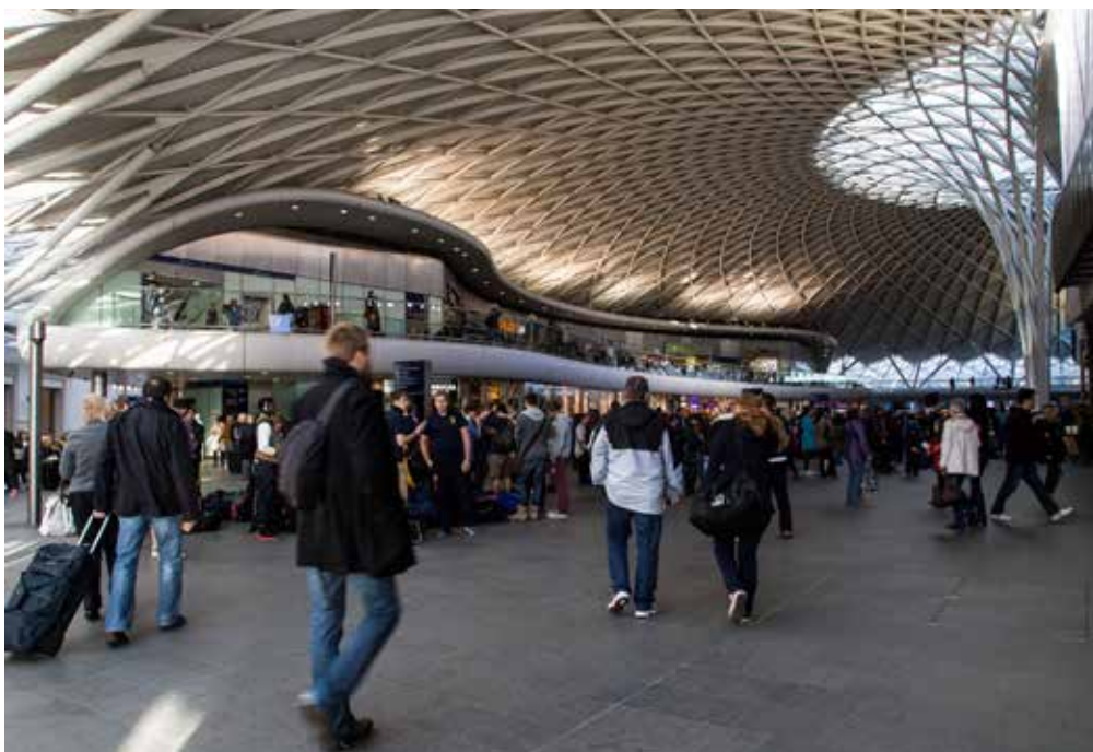
Kings Cross Station i London er modernisert og bygget på for å møte togkundernes behov
